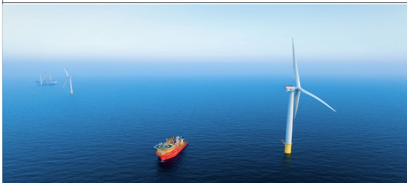
写真提供元：Dogger Bank Wind Farm
